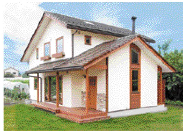
縦長にレイアウトされた天然木の壁とそれにつながる煙突がアクセント。見る方向によって多彩な表情を持つ家だ。
