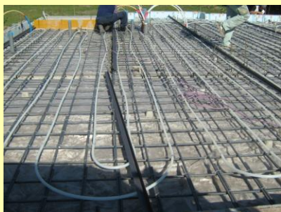
2月上旬 前橋市天川原町 基礎の鉄筋や床暖房の様子が確認できます。
