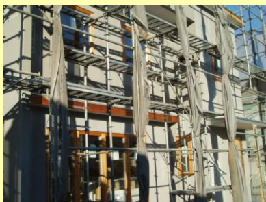
伊勢崎市境保泉と高崎市棟高町で 2月中旬頃 漆喰を塗っている様子が確認できます。 世界の長谷川に会えるかも。
