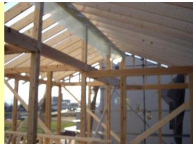
前橋市天川原町 2月中旬頃 上棟した現場を確認できます。柱梁などの実物が確認できます。
