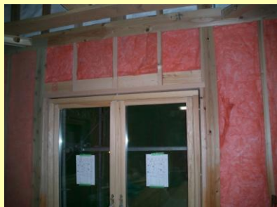
高崎市箕郷町 2月上旬頃 暖かさの秘密である断熱・気密工事確認できます。
