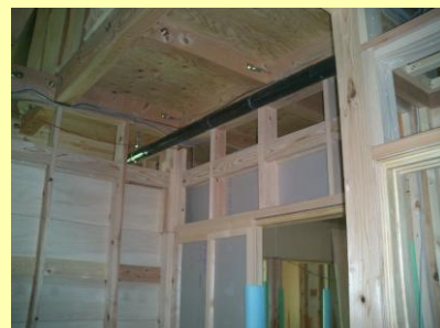
前橋市箱田町で2月中は 大工工事の様子が確認できます。 室内の配管や配線なども見られます。
